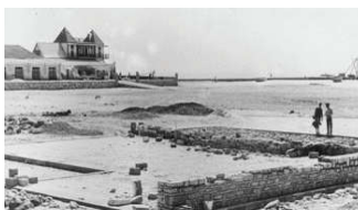
As fundações da casa original (1966)
