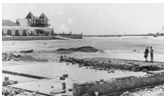
As fundações da casa original (1966)
