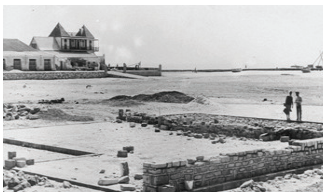
Das Fundament des ursprünglichen Hauses (1966)
